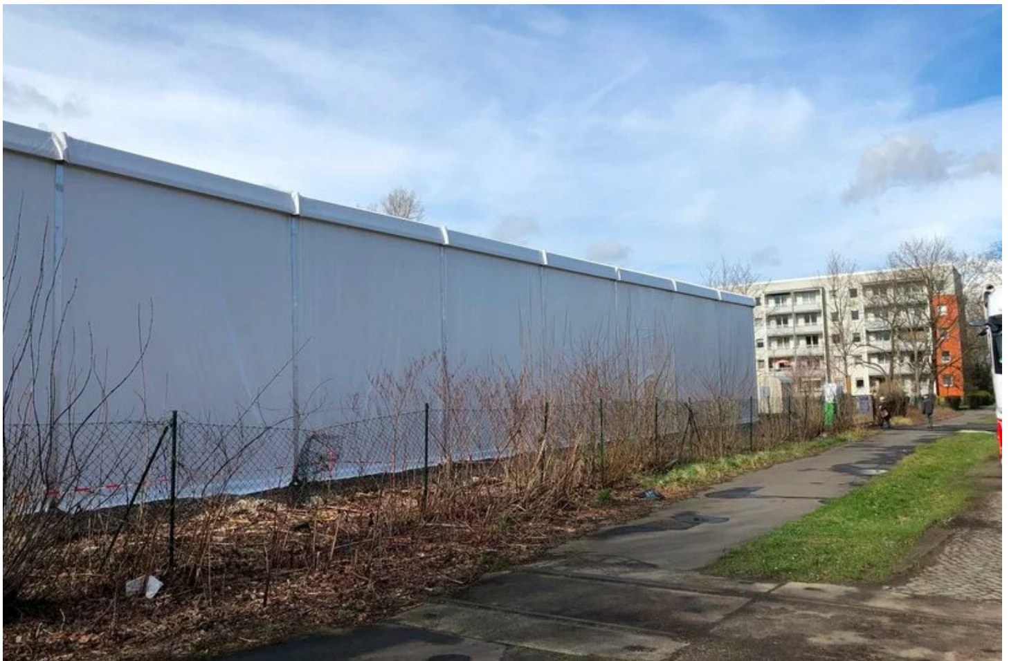
Altlastensanierung an der alten Teerpappenfabrik.
